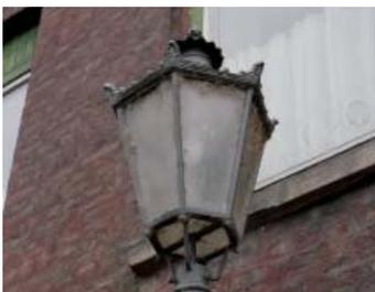
Aufgrund fehlendes IP-Schutzes sind die Leuchtenköpfe teilweise stark verschmutzt.
