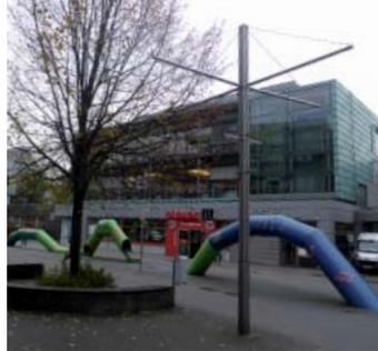
Sonderleuchten mit klappbarem Ausleger, einfach und vierfach Lichtpunkthöhe 4,70m
